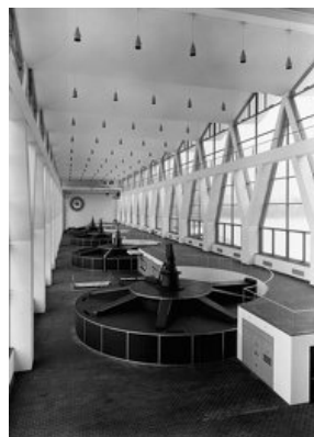
© Kraftwerk Birsfelden AG
