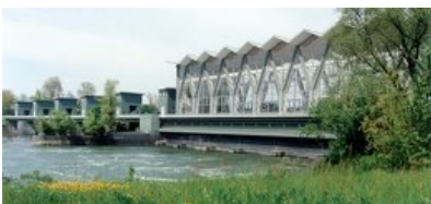
© Kraftwerk Birsfelden AG
