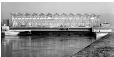
© Kraftwerk Birsfelden AG
