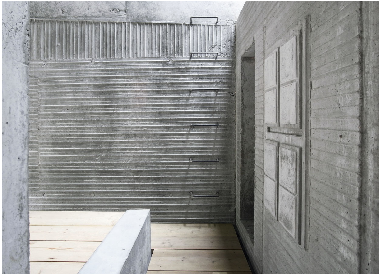
Blick auf die Innenwände der neuen Hütte mit dem Abguss der Holzwände des alten B26-Bungalows.
