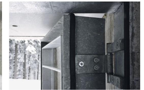
Stahlfassung für 200 kg Betontür
