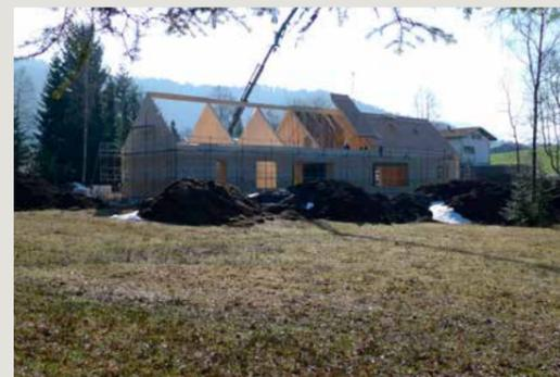
Versetzen der Dachelemente mittels Kran
