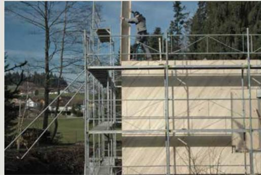
Hochwärmegedämmte, vorgefertigte Elemente
