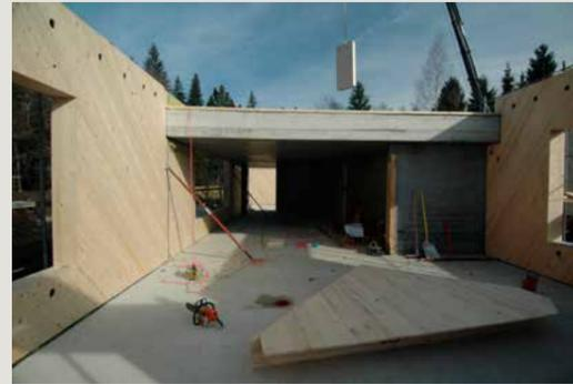
Verbindung der Holzelemente mit der Betonkonstruktion
