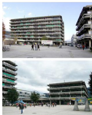
© ATP architekten ingenieure
