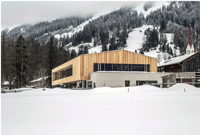
© ATP architekten ingenieure
