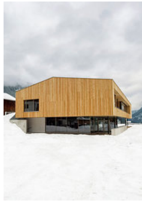
© ATP architekten ingenieure
