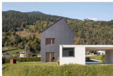
© Nadia Vontobel Architekten GmbH
