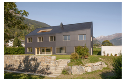
© Nadia Vontobel Architekten GmbH
