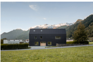
© Nadia Vontobel Architekten GmbH
