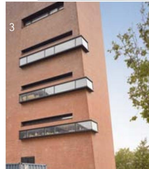
Die Mehrzahl der Fenster ist zweiteilig und besteht jeweils aus einem horizontalen Band und einer darüber liegenden »Lichtleiste«
