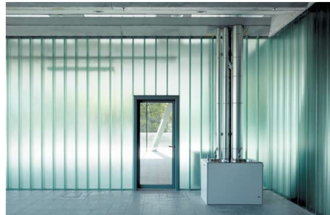
^ Der Blick aus einem Schulzimmer. Die sichtbaren Wasserleitungen wurden übrigens erst nach akustischen Tests bewilligt.
