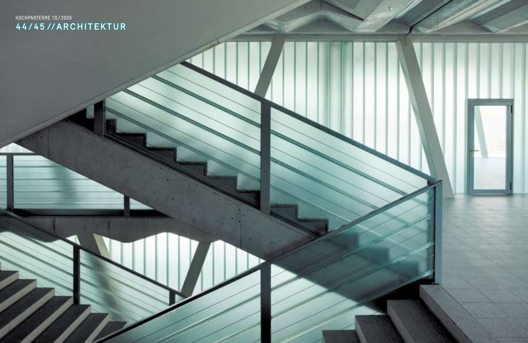
^ Zwei gegenläufige Treppen erschliessen alle Geschosse. Industrieglas bringt dumpfes Licht nach innen.
