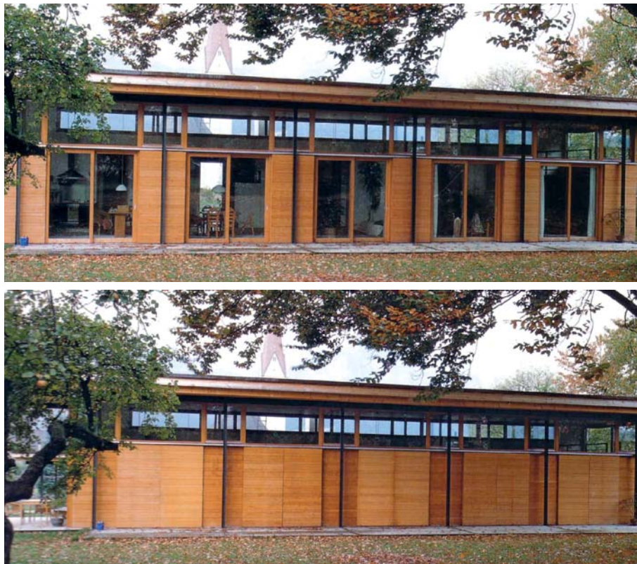
Abbildung 1. Beispiel „Sachlicher Pavillon“ (Margarethe Heubach-Sentobe): Über die Mischung von Leichtigkeit und Schwere wird sowohl Bodenständigkeit als auch eine einladende Offenheit thematisiert (Dworschak 1999, 185). Konstruktiv basiert das Bauwerk auf einer konsequent systematisierten Planung, die eine werkseitige Vorfertigung der einzelnen modularen Elemente ermöglichte; die klare Ablesbarkeit des Konstruktionsrasters verleiht auch eine unverkennbare, minimalistisch elegante Gestaltwirkung.
