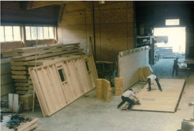
Abb. 2-3: Handwerkliche Vorfertigung von Tafелеlementen in Holzrahmenbauweise (Quelle: bauart)
