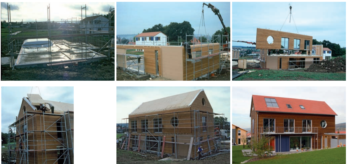
Abb. 2-7: Montage eines Holzhauses in Holzrahmenbauweise aus vorgefertigten Tafелеlementen innerhalb eines Tages, fertiges Gebäude (Quelle: bauart)
