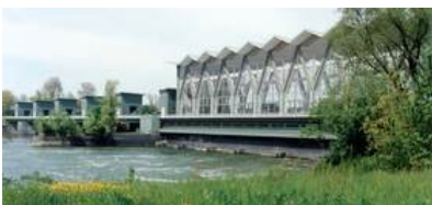
© Kraftwerk Birsfelden AG
