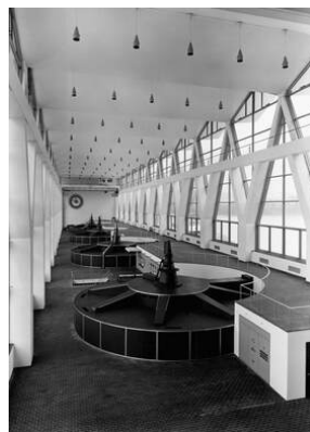
© Kraftwerk Birsfelden AG
