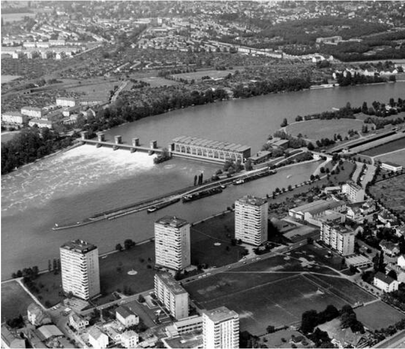
© Kraftwerk Birsfelden AG
