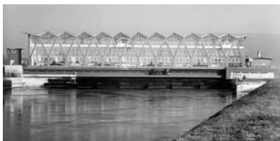
© Kraftwerk Birsfelden AG
