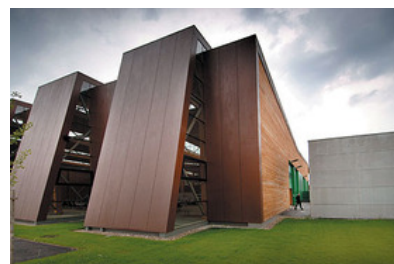
© Obermayr Holzkonstruktionen GesmbH
