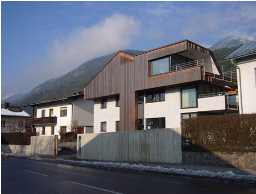
© Fügenschuh Hrdlovics Architekten
