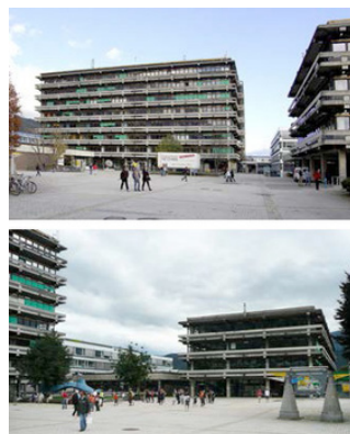
© ATP architekten ingenieure
