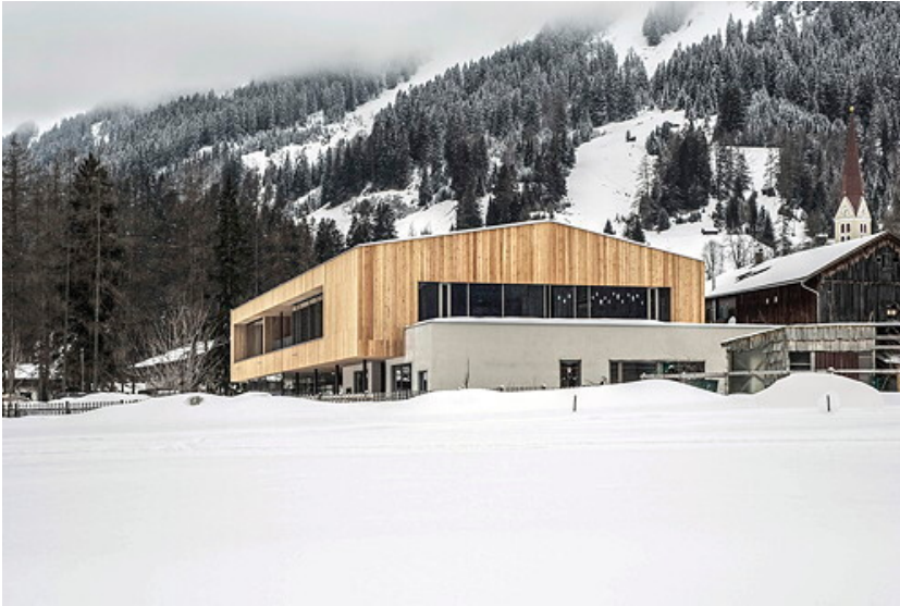
© ATP architekten ingenieure
