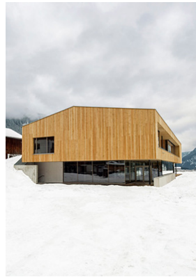
© ATP architekten ingenieure
