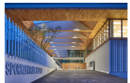
© Stadt Zürich, Amt für Hochbauten; Foto: Theodor Stalder, Zürich
