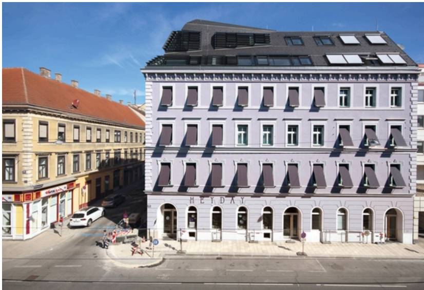
© BMNT / Trimmel Wall Architekten
