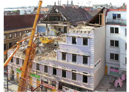
© Trimmel Wall Architekten
