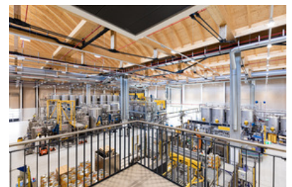
© ATP architekten ingenieure
