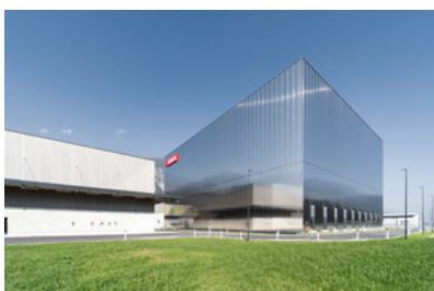
© ATP architekten ingenieure
