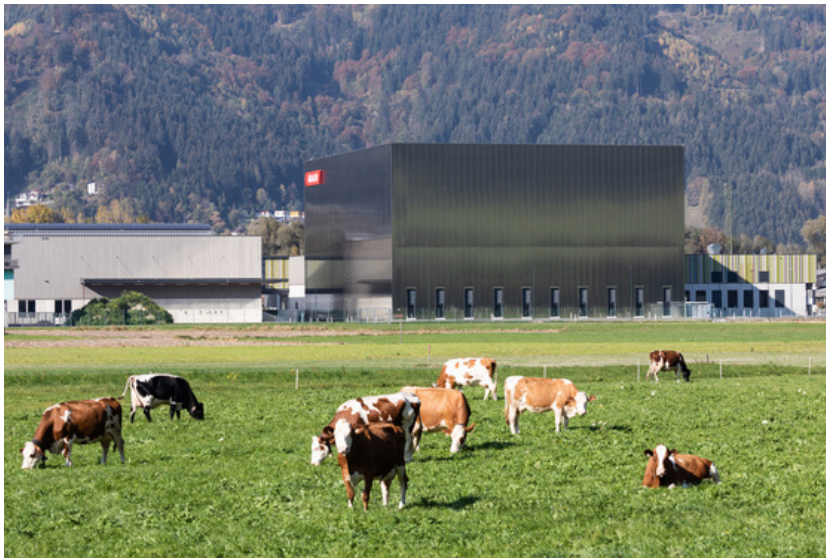
© ATP architekten ingenieure
