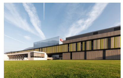
© ATP architekten ingenieure
