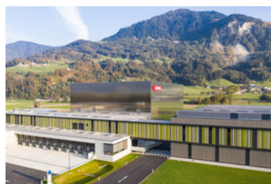
© ATP architekten ingenieure
