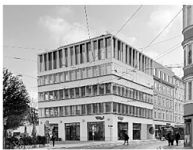
2003 - Neugestaltung des Kopfbauteiles und Aufstockung Henke und Schreck Architekten
