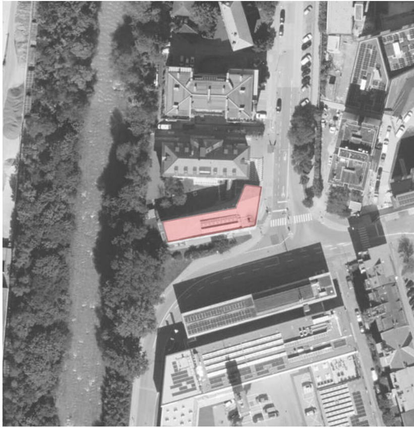
Erweiterung der städtischen Herberge - Pflegestation
